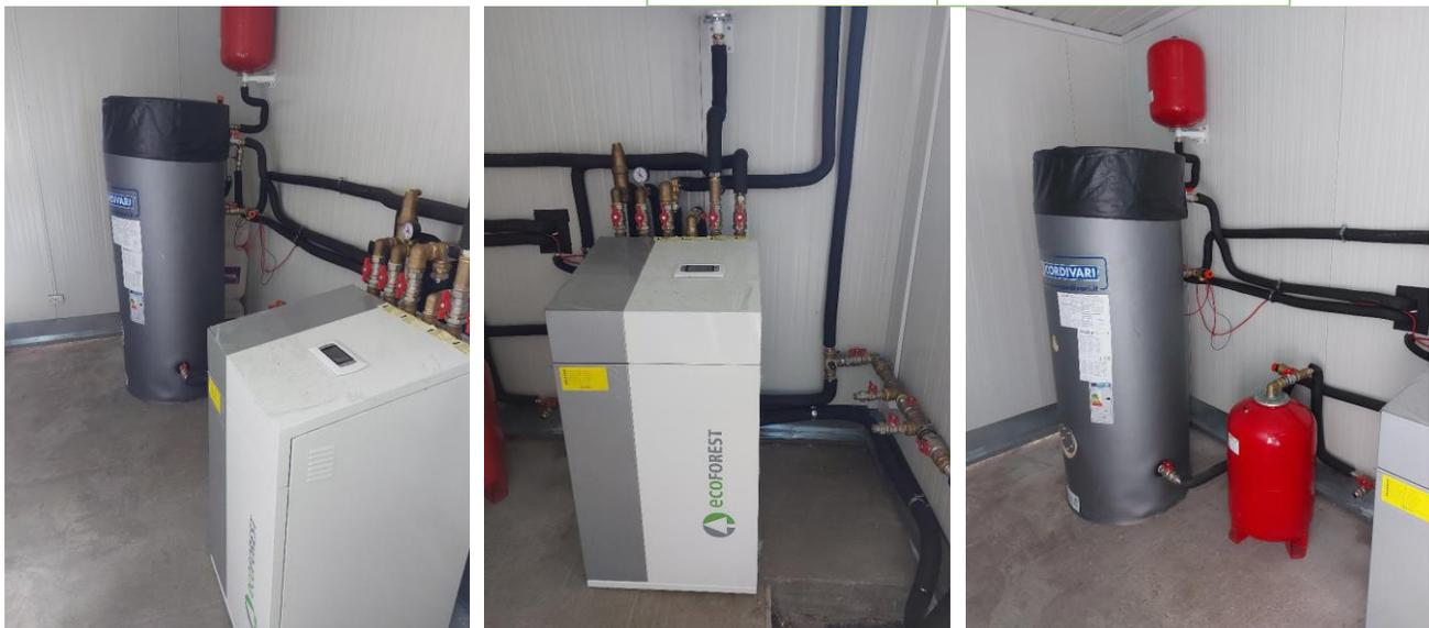
Figura 6. Montajul final al pompei de caldura in container
