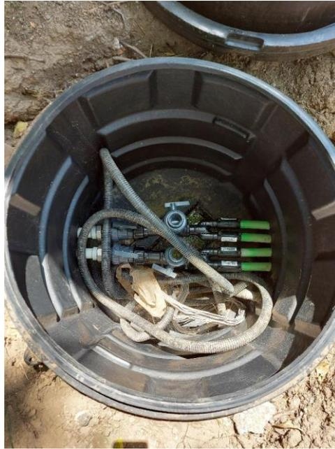
Figura 7. Manhole pentru conectarea schimbatorului de caldura cu pamantul cu conductele de legatura catre container si cablul cu termocuplurile pentru masurarea temperaturilor in foraj
